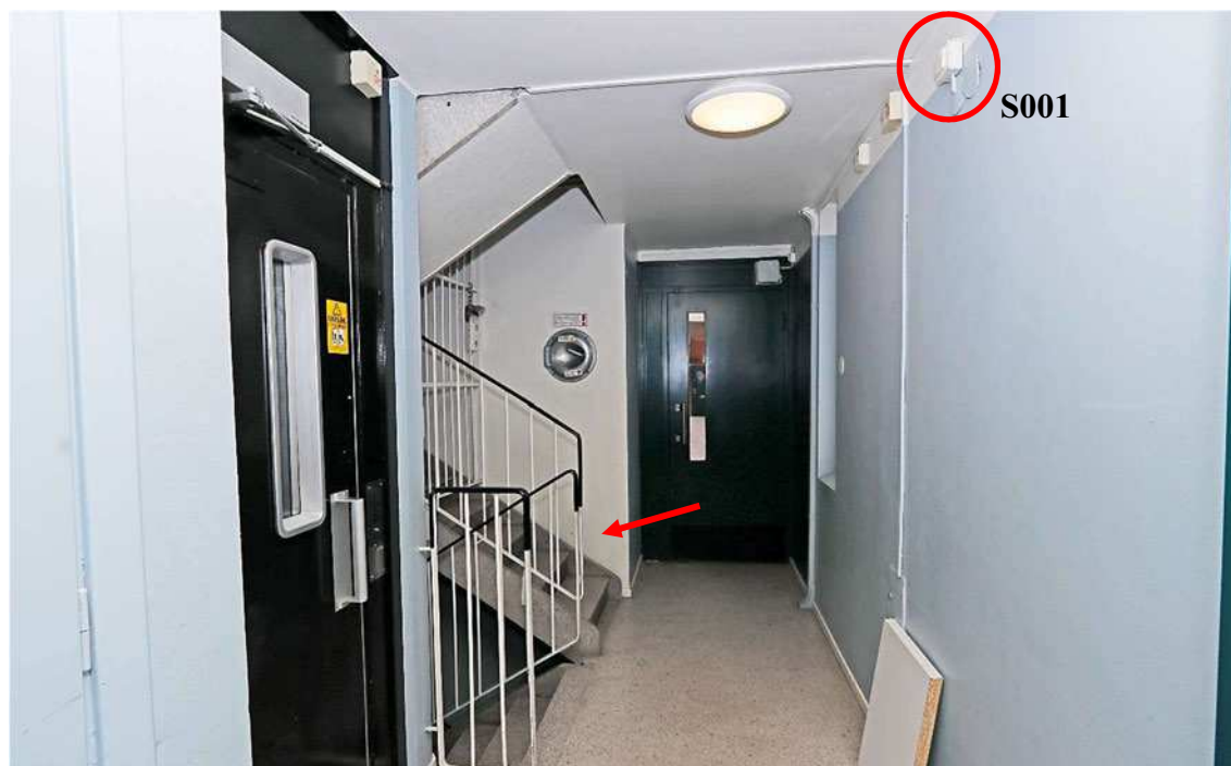
Figur 1. Trapphuset vån 6. Markering för trappen upp till vinden, samt eluttaget (S001).
