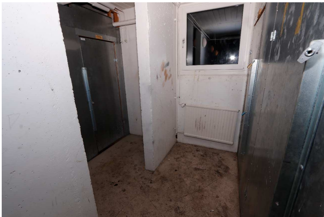
Figur 1. Aktuell del av källarutrymmet.
